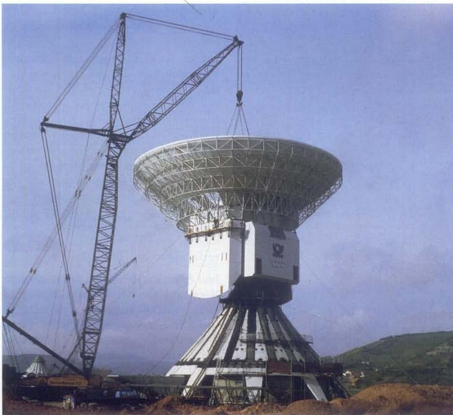
Bild 2 Heben des Reflektors der Antenne Fuchsstadt 1
